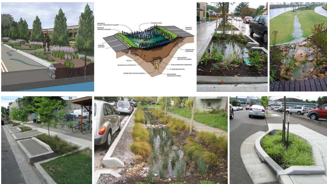
(Kép: Vízkörforgás menedzsment bemutatása - Bioswale)
