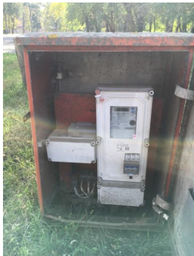
jelenlegi fogyasztásmérés szekrény (ajtó nélkül)
